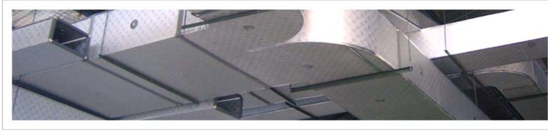
الشكل 1.3 مجرى الهواء مسبق العزل
